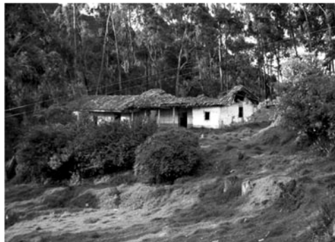
Figura 6: Casa del administrador de la Real Salina de Tausa, 2005.
