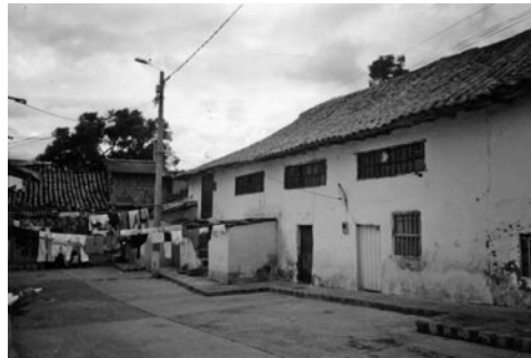
Figura 14: Aspecto actual de la fábrica.
