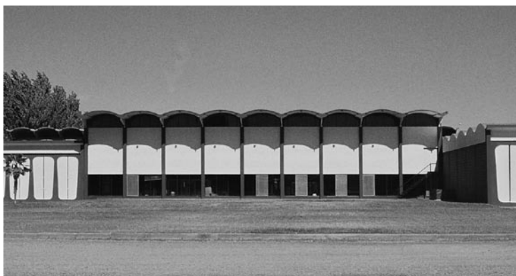
Figura 13: Bodega Etchart (Luján de Cuyo). Vista general de las naves industriales, 2007.
