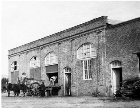
Figura 7: Bodega Toso. Fachada tipo pantalla oculta la nave industrial.
