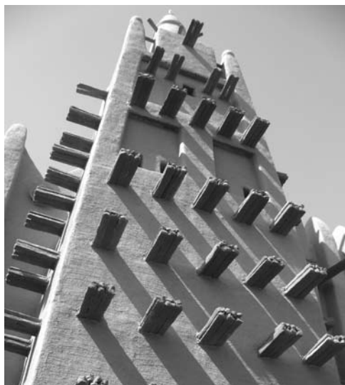
Figura 5: Restauración de la mezquita de Mopti, Mali.
