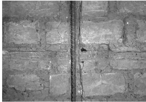
Figura 37: Instalación de las barras.
