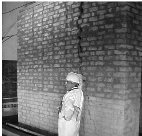
Figura 14: Montaje y mecanismo de falla del primer muro. Grieta vertical dominante debida a tensión en el mortero.
