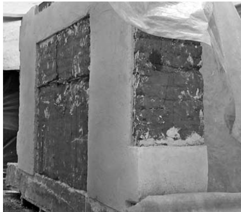
Figura 6: Muro reforzado con malla de vena pañetado.
