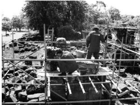
Figura 15: Interior, iglesia San Juan Baptista, obras de 2005.
