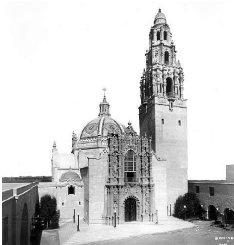
Figura 7: Edificio California. Parque Balboa. San Diego (USA).
