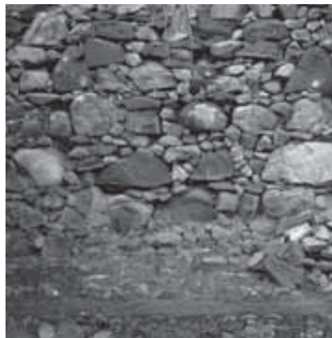
Figuras 5 a 8: Fuerte de Santo Antonio, Ilha de Ratonas, Santa Catarina: después de la intervención de 1990. Parcialmente reconstruido con piedras de ruinas y revocado para distinguir el material de la propia ruina.
