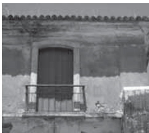
Figura página anterior: Cuartel de la tropa de la fortaleza de Santa Cruz de Anhatomirim, 2004. Edificio emblemático. Restaurado manteniendo el aspecto "texturizado" de las superficies del revoque.
