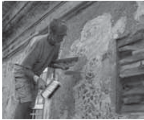
Figura 24: Aplicación de argamasa para rellenar vacíos y regularizar la superficie, (mezclada en proporción 1:3,5 pasta de cal y arena gruesa) intercalada con fragmentos de teja, 2005.
