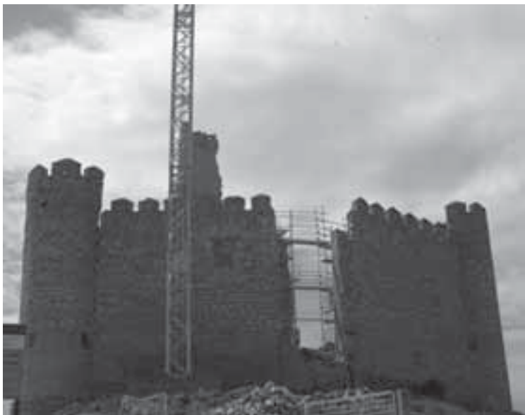
Figuras 20 y 21: Castillo de Embid, España, 2005. Proyecto y obra coordinada por el IPHE. Inicio de los trabajos de sustentación de los paramentos y torres utilizando argamasas de cal aérea y mezclas con tierra de varios colores.
