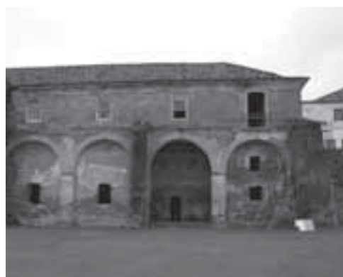
Figuras 3 y 4: Cuartel de la tropa de la fortaleza de Santa Cruz de Anhatomirim, 2004-2005. Edificio emblemático. Restaurado manteniendo el aspecto "texturizado" de las superficies del revoque.
