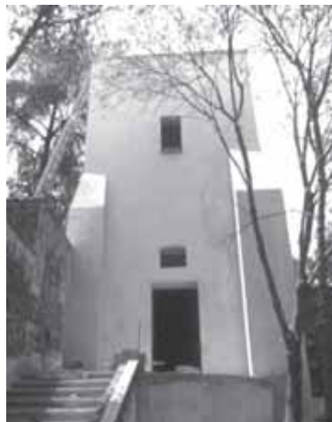
Figuras 4 y 5: Osario antes y después de la restauración, 1993-1996.
