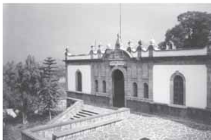
Figuras 1 y 2: Fachada principal, Portal de ingreso, 1995.
