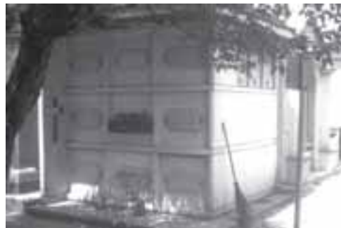
Figura 25: Construcción de tres niveles, con espacio para gavetas y nichos. Está hecha de tabique y concreto armado y tiene recubrimiento de mármol (7.9).
