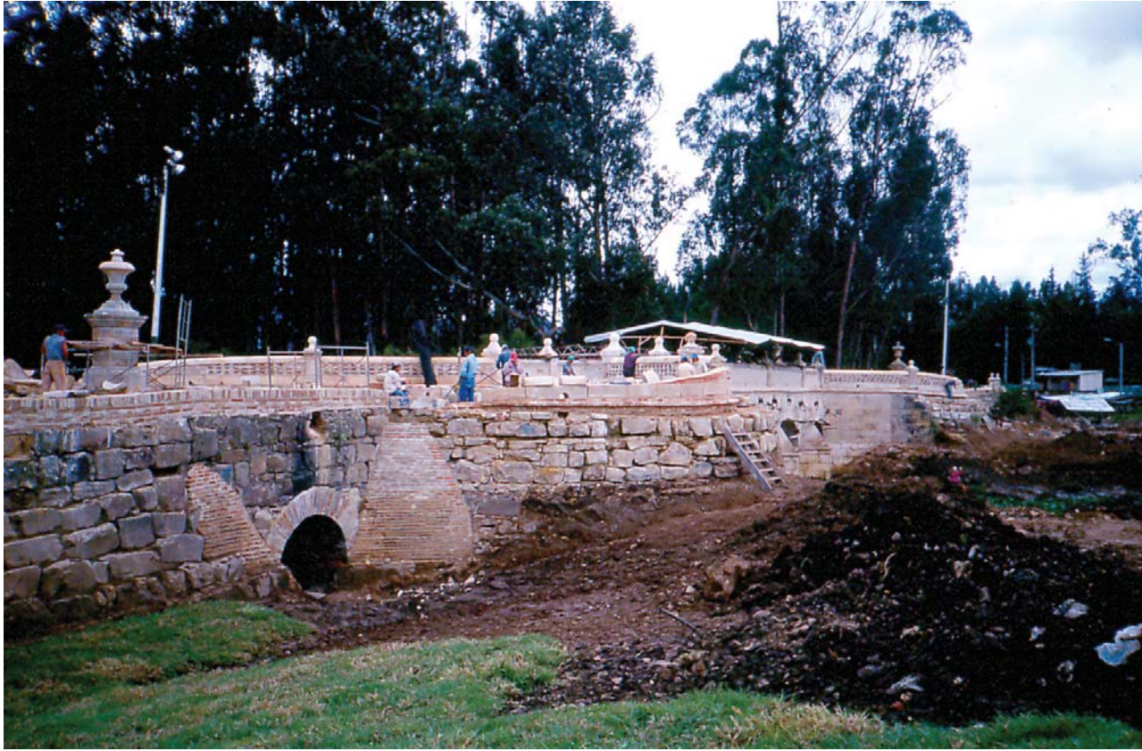
Movimiento de tierras para liberar las bases de los camellones de aproximación al puente. 1997.
