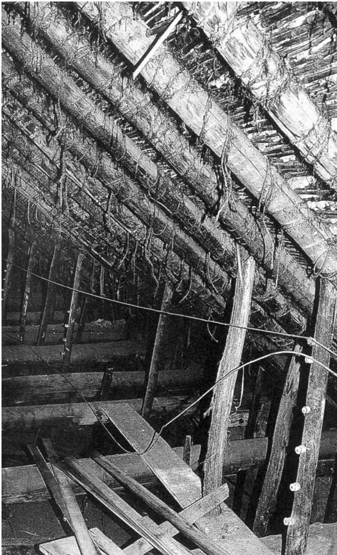
Armadura de cubierta de la Iglesia de San Agustín, Bogotá. Estado de la armadura antes de iniciar el proceso de restauración.
