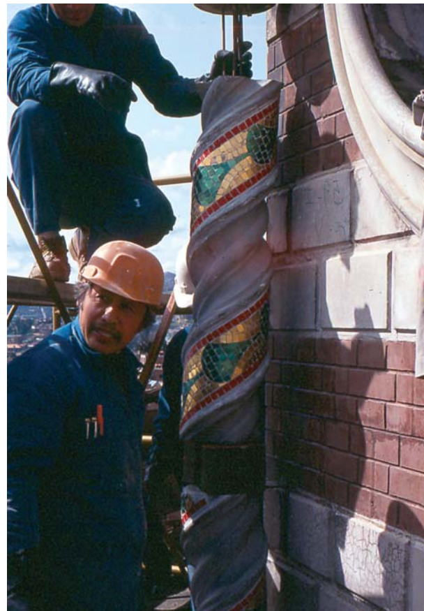
Proceso de reposición de una pilastra de la torre del templo de Nuestra Señora del Carmen en Bogotá.
