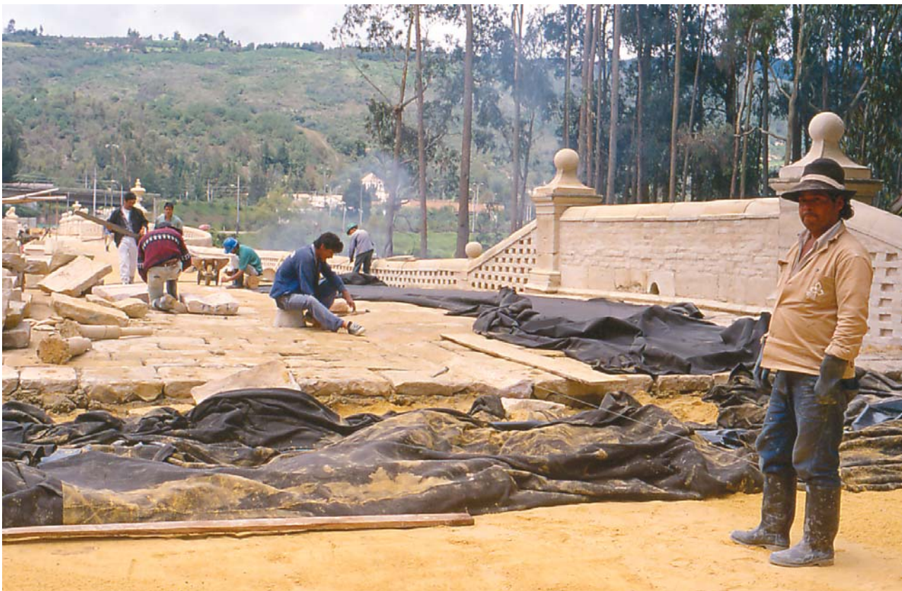
Aplicación de geotextil bajo la calzada en piedra. 1997.
