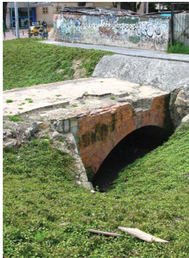
Detalle del puente siglo XIX encontrado durante el proceso de las obras. 2003.
