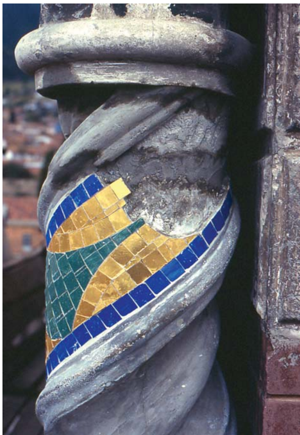
Detalle elaboración del montaje de dos secciones de la pilastra. El mosaico aplica de manera que disimule el empate de las piezas. Foto: María Victoria Vieco. 1992.
