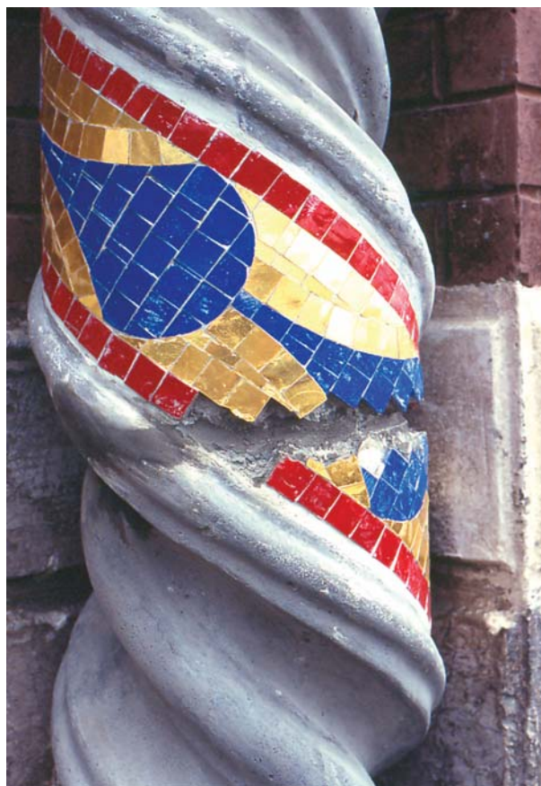
Detalle elaboración del montaje de dos secciones de la pilastra. El mosaico aplica de manera que disimule el empate de las piezas. Foto: María Victoria Vieco. 1992.
