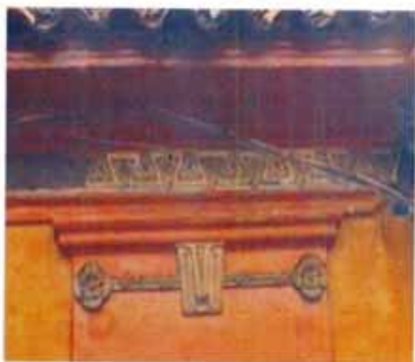
Detalle pilastra en la casa de la calle 1C entre carreras 8 y 9.
