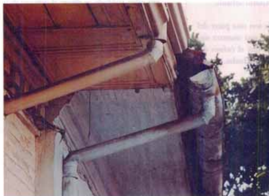
A. En esta foto se ve un ejemplo de canal moldurada, en ambos casos se observa la solución para llevar la bajante pegada o embobida en el muro.
