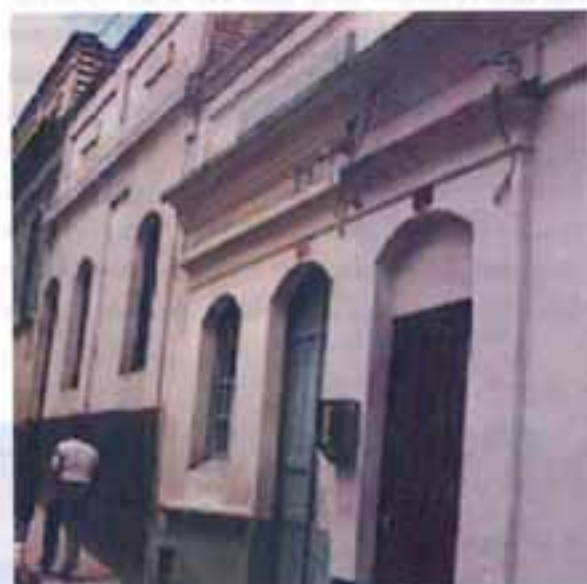
Calle 1C entre carreras 6 y 7.
