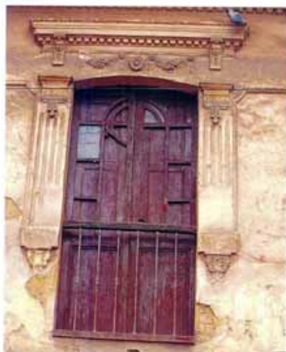
Ventana del Colegio Parroquial de San Pedro, carrera 7 entre calles 2 y 3, sobremarco en ladrillo pautado, molduras en cemento, ventana en madera y baranda. Uno de todos los recursos decorativos posibles.
