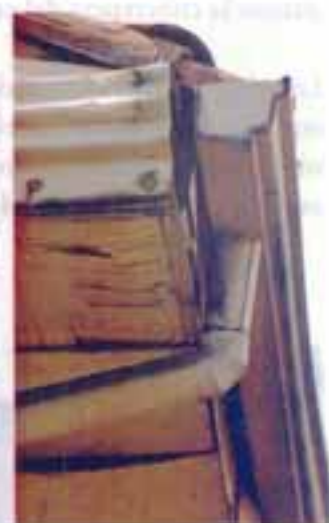
A. En esta foto se ve un ejemplo de canal moldurada, en ambos casos se observa la solución para llevar la bajante pegada o embobida en el muro.
