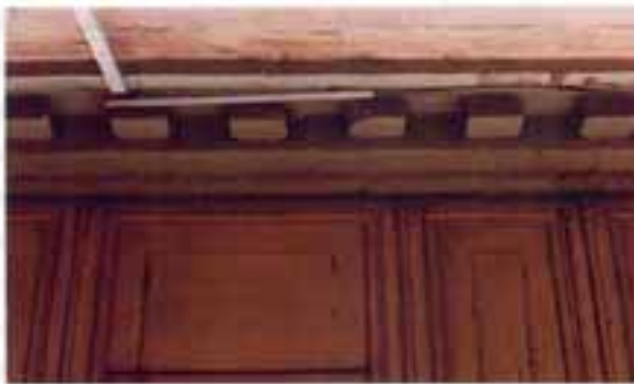
En la foto se muestra una cornisa denticulada, construida en ladrillos de la fábrica de Ricardo Calvo.
