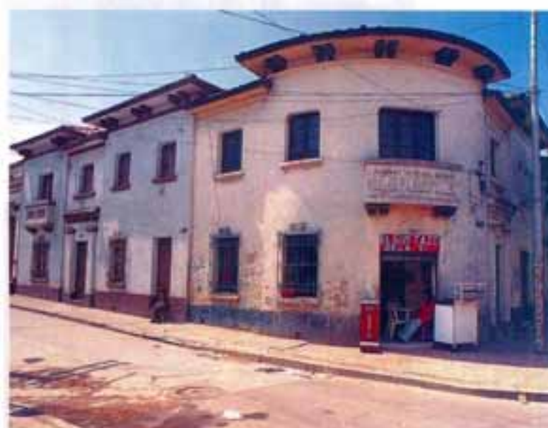
Carrera 7 calle 3 esquina.
