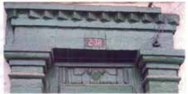
En la foto se ve la parte superior de una portada con moldura en dentículos de ladrillo.
