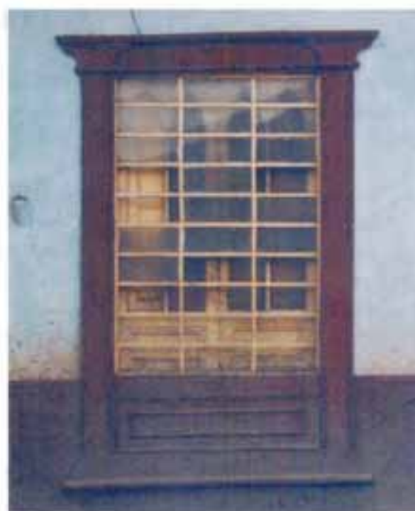
Otra muestra del trabajo en madera es la que se observa en este marco, donde se trabajan molduras como si fueran piedra o ladrillo. Tras los vidrios se alcanza a apreciar el elaborado trabajo de la ventana con postigo.
