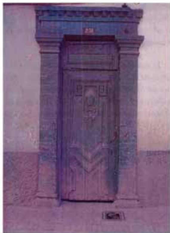
Carrera 7 No. 2 - 38. Portada en ladrillo sin pañetes, acompañada de una puerta en madera trabajada de gran riqueza plástica. Estas portadas por lo general se encuentran en fachadas del grupo 1 y van acompañadas de ventanas de proporción casi cuadrada, con rejas arredilladas o con pecho de paloma.
