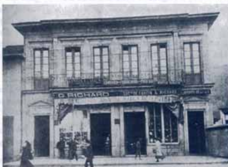
Almacén Casa Richard
