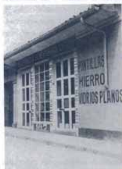
Almacén Echavarría, Calle 13 No. 167
