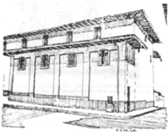
Esquina de la Carrera 4 con Calle 7, antes de iniciarse los trabajos de restauración.
