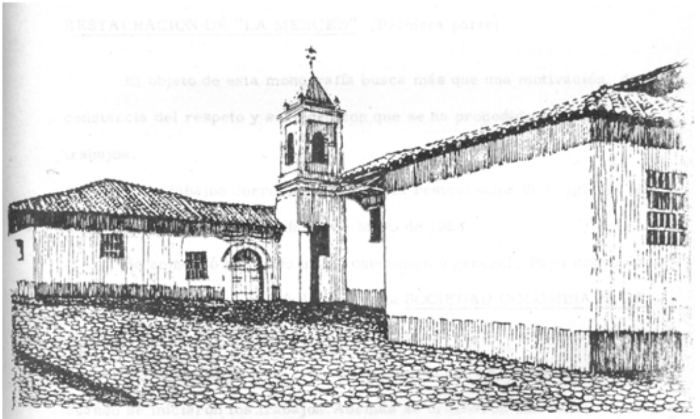
Iglesia de La Merced en Cali. Restauración de La Merced. Esta monografía busca más que una motivación, dejar constancia del respeto y seriedad con que se ha procedido a ejecutar los trabajos.
